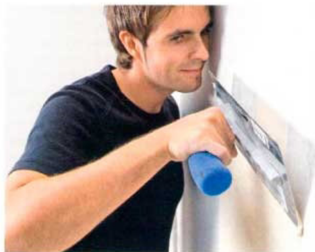
Dass Trockenbauen bei Heimwerkern beliebt ist, liegt an den leicht zu verarbeitenden Bauprodukten wie dem „Uniflott“ von Knauf Bauprodukten. Deren aufeinander abgestimmte Komponenten ermöglichen dem Laien professionell aussehende Ergebnisse. Foto: djd/Knauf Bauprodukte
