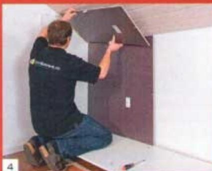
4 Die Rückwand wird eingesetzt und mithilfe eines Verbindungsstücks mit den Seitenwänden verschraubt, was für Stabilität sorgt.
