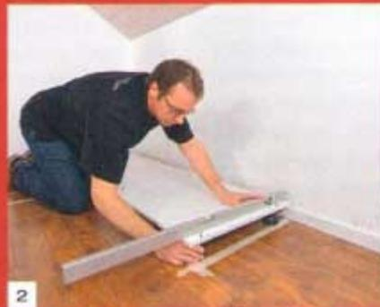
2 Mithilfe der Wasserwaage können Sie dann die Füße perfekt ausrichten. Ungerade Böden sind somit kein Problem.
