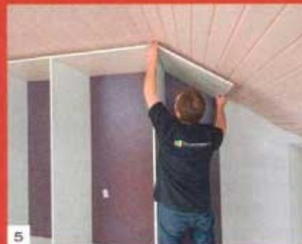
5 Der Deckel sitzt auf der Rückwand des Schränks und verbindet die einzelnen Mittelseiten fest miteinander.
