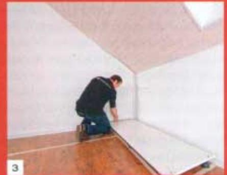
3 Anschließend setzen Sie die erste Außenwand auf den Boden – der Schrank wird nämlich dort aufgebaut, wo er später stehen soll.
